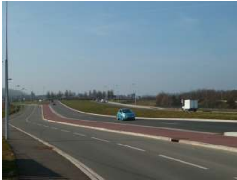
RD 113, séparant La Coudraie et Poncy - source Ville- DPUGPU - 2012
