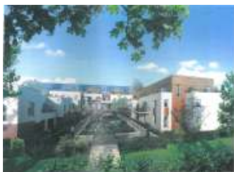
Lot J : MO France Habitation, Architectes : Atelier d'Architecture DCE
