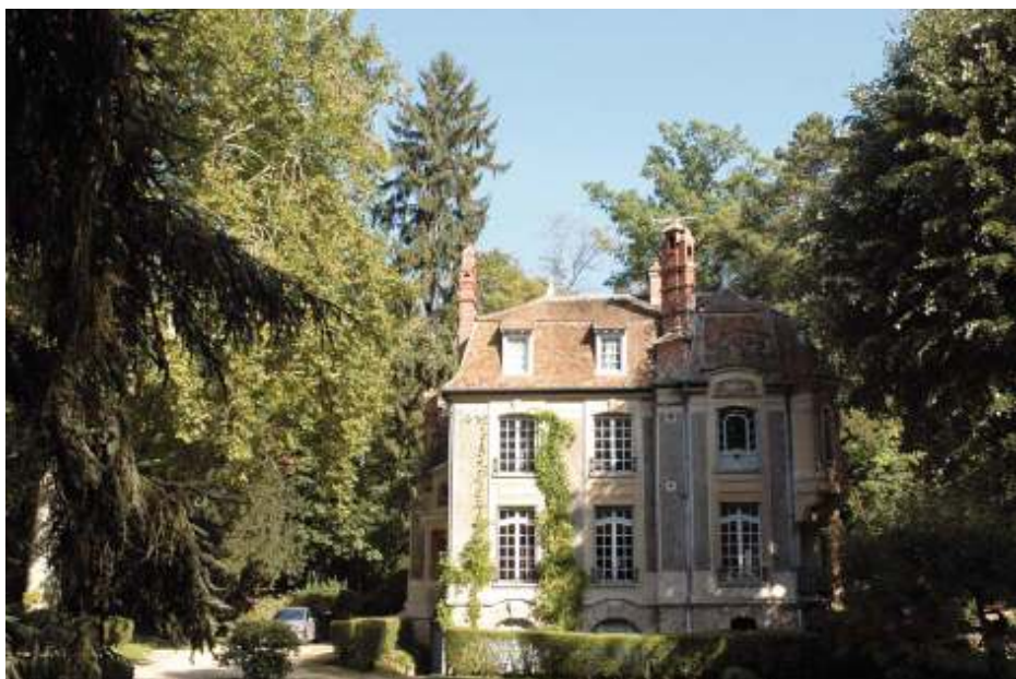
Bâtiment principal d'habitation (Monument Historique Inscrit)
