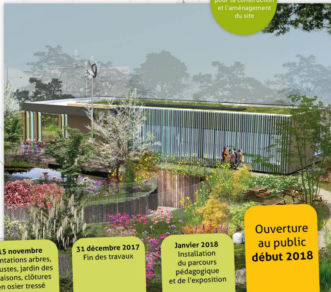
La Maison de l'eau de 100 m<sup>2</sup> pour accueillir exposition et ateliers conçue de manière écologique (végétalisée, cuve de récupération des eaux pluviales, noues, éolienne, panneaux solaires...)
