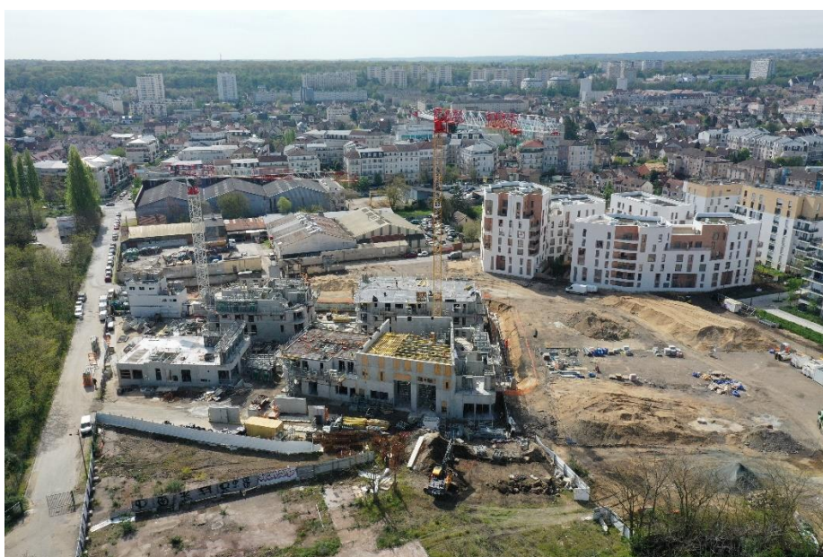
Résidence Isle-au-Vert en travaux (lot G1) - mai 2023
